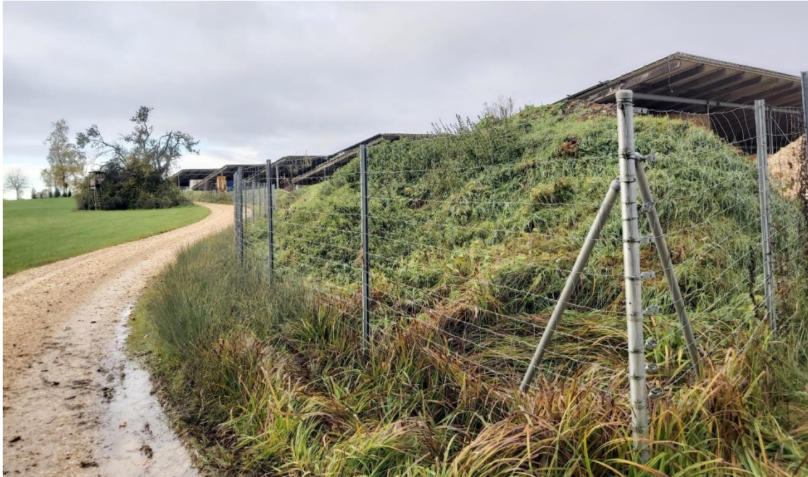
Abbildung A. 1: Blick Richtung Süden entlang des Zauns im Osten
