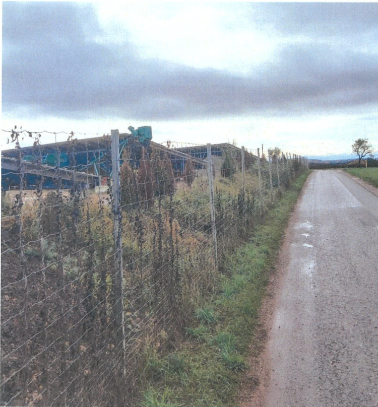
Abbildung A. 4: Blick Richtung Süden entlang des Zaunes im Westen
