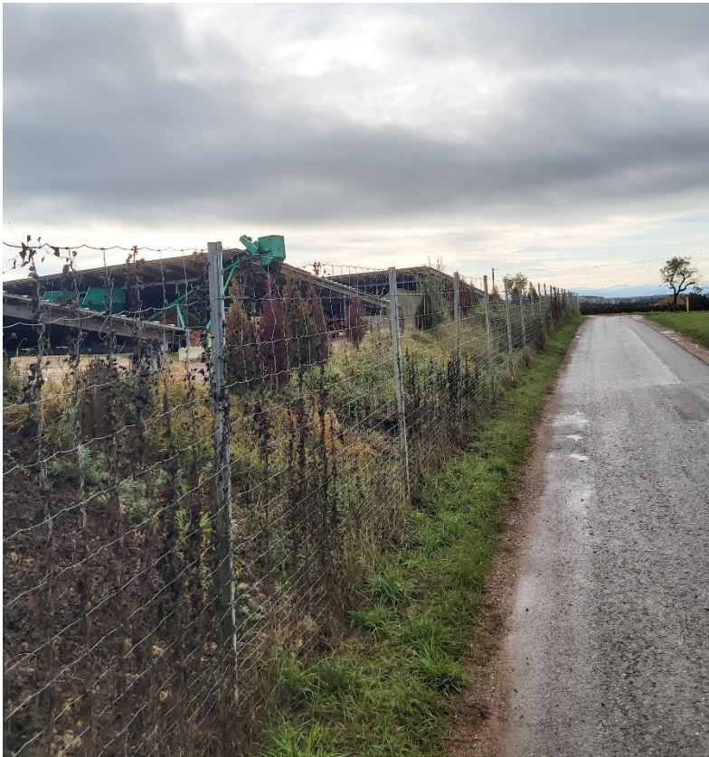
Abbildung 7: Blick Richtung Süden entlang des Zaunes im Westen
