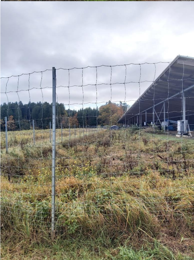
Abbildung 8: Blick Richtung Osten am nördlichen Ende der PV-Anlage
