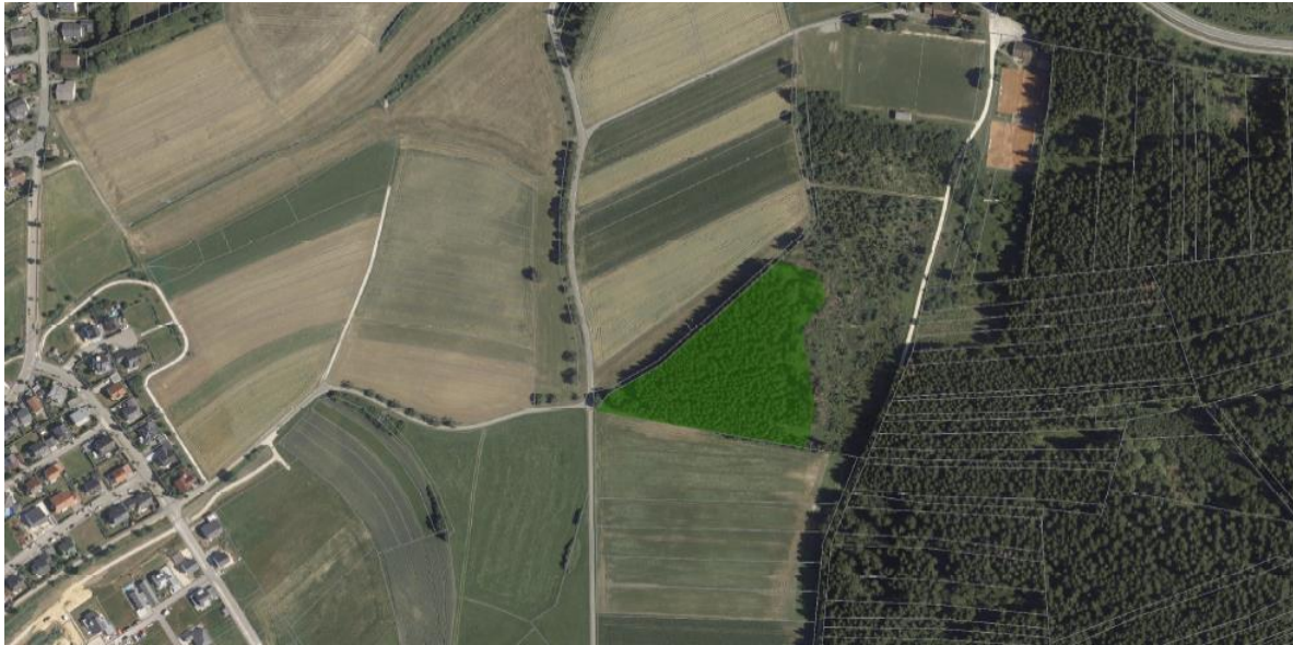
Abb. 24: Maßnahmenfläche im Luftbild
