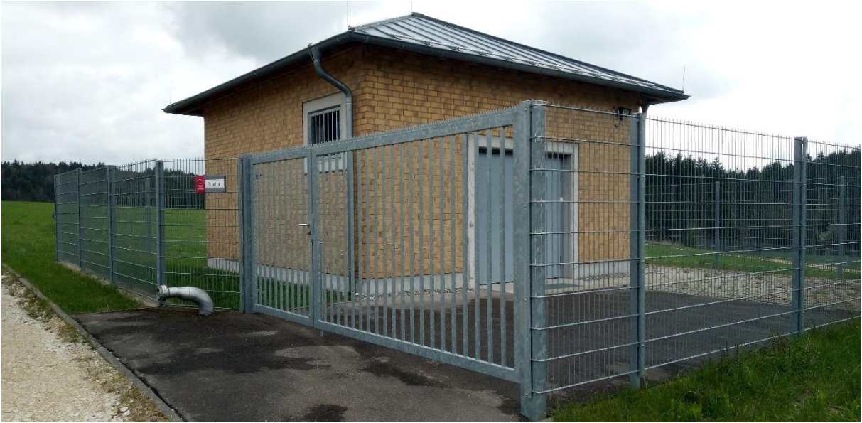
Abb. 16: Technikgebäude mit gepflasterter und asphaltierter Fläche
