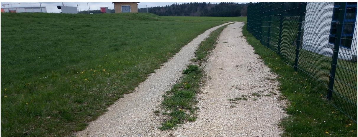
Abb. 18: Schotterweg am Gelände der Kläranlage
