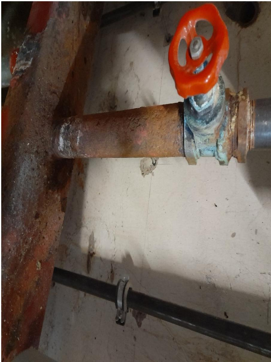
Der Gemeinde wurde dringend empfohlen, eine Heizungswasseraufbereitung nach VDI2035 durchzuführen und die Heizkreisanschlüsse am Heizungsverteiler erneuern zu lassen. Ein Angebot liegt zum Zeitpunkt der Vorlagenerstellung bereits vor, ein Vergleichsangebot wird bis zur Sitzung noch eingeholt. Die Kostensituation wird in der Sitzung erläutert werden.
